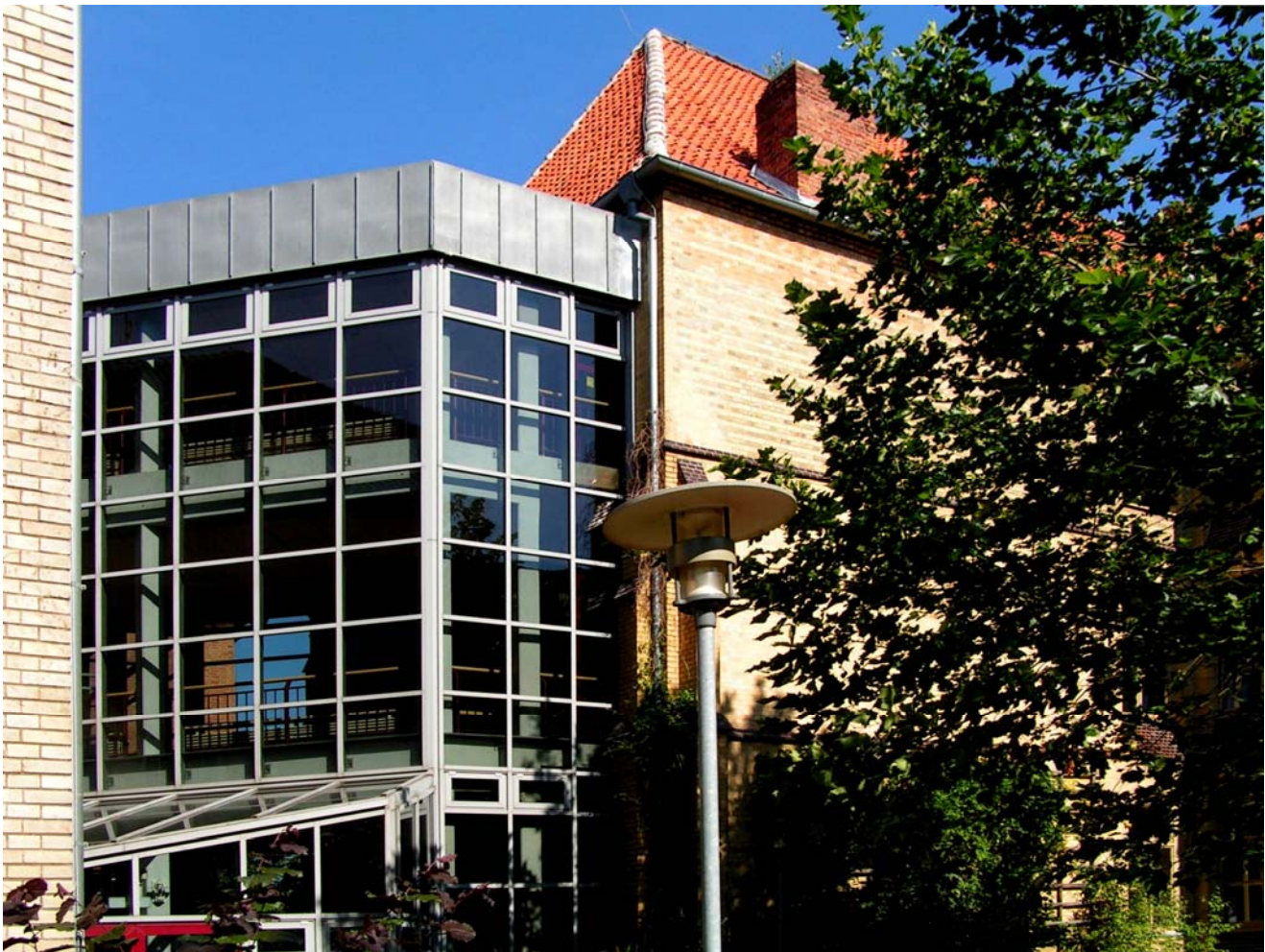
Blick vom Schulhof auf Altbau und Foyergebäude. Foto: Schalles
